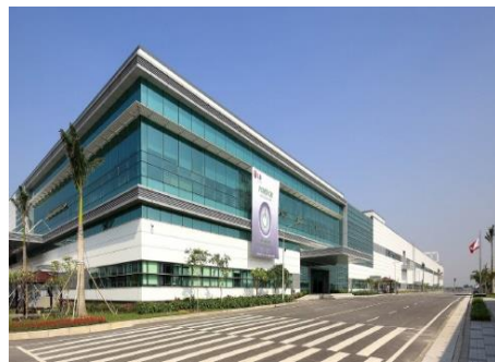
하이퐁 LG전자 공장 시공사 : GS건설/서브원 건설
