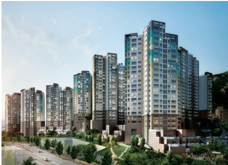
녹번동 래미안 베라힐즈 시공사 : 삼성물산
