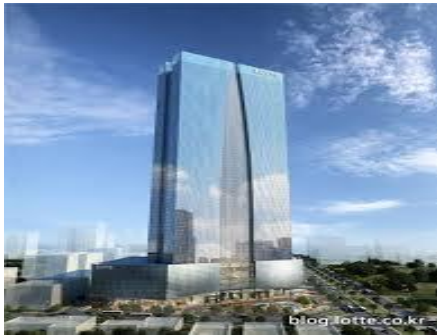
하노이 롯데센터 시공사 : 롯데건설
